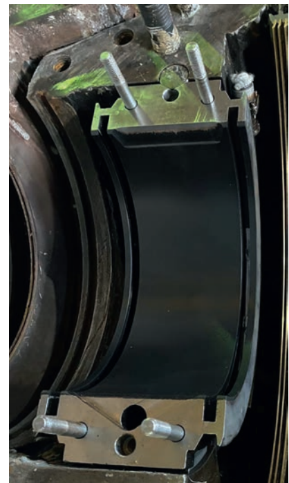
Рис. 5. Опорный подшипник ротора осевого компрессора турбины высокого давления после 3016 ч эксплуатации Fig. 5. Journal bearing of the high-pressure turbine axial compressor rotor after 3016 h of operation
