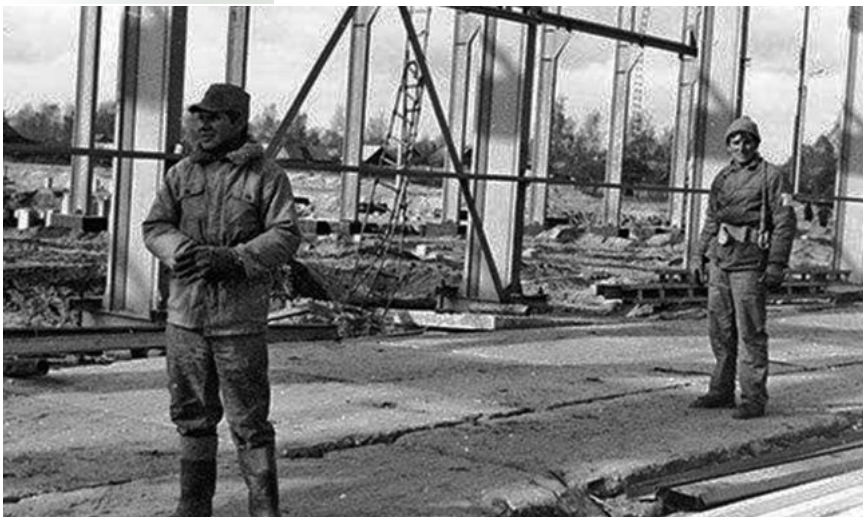
С Строительство завода по ремонту газотурбинного оборудования для газопровода Уренгой – Помары – Ужгород, г. Брянск, 1989 г.
