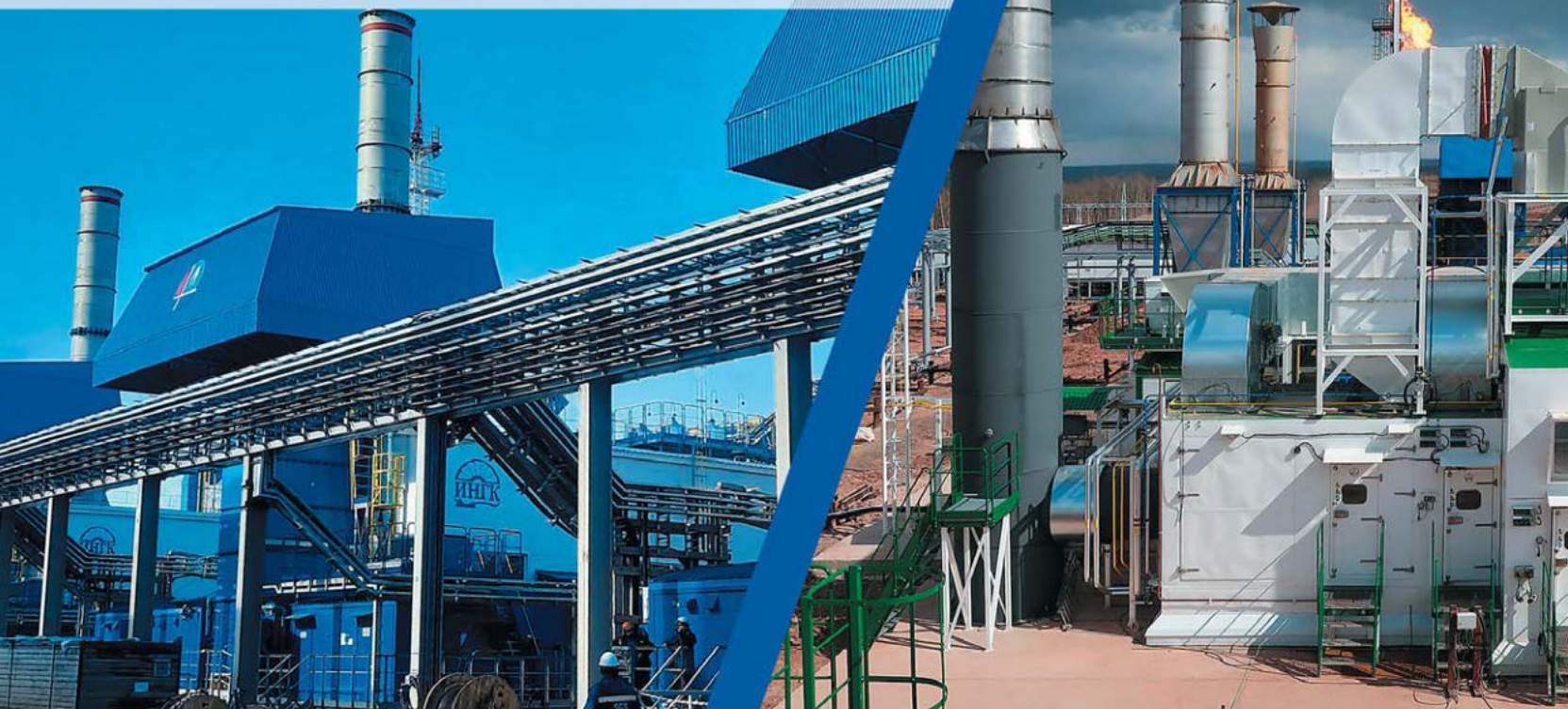
ГПА-16 МВт «Иртыш», 6 шт. ДКС Южно-Русского НГКМ, ОАО «Севернефтегазпром»
